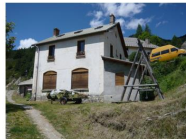
Ecole désaffectée du hameau Les Meyries Commune de Chateau-Queyras (05)
